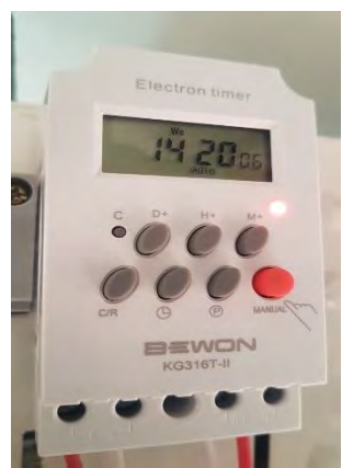
Timer switch เปิด ปิด แอร์ตามเวลาที่กำหนด
